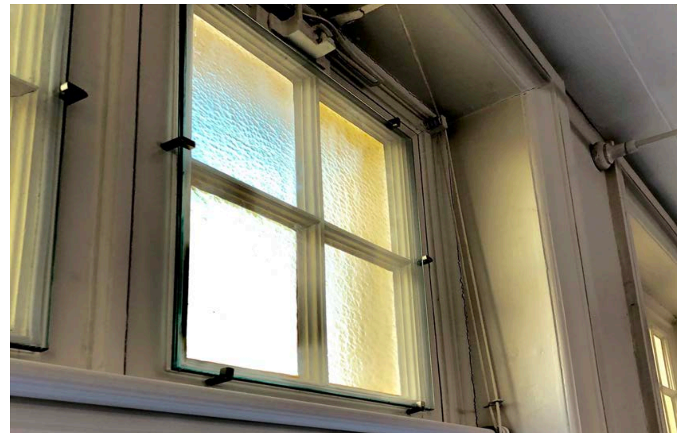
▲ Afbeelding XXXIV Achterzetgeglazing op een historisch valraam met geel kathedraalglas.
