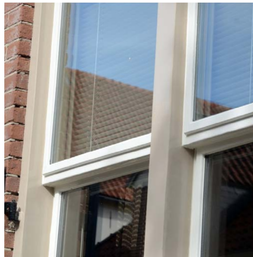
▲ Afbeelding XXXII Schuiframen met opdeklaten vanwege het plaatsen van isolatieglas. Door de latten schuift het onderaam niet meer omhoog en is het aanzicht gewijzigd.
