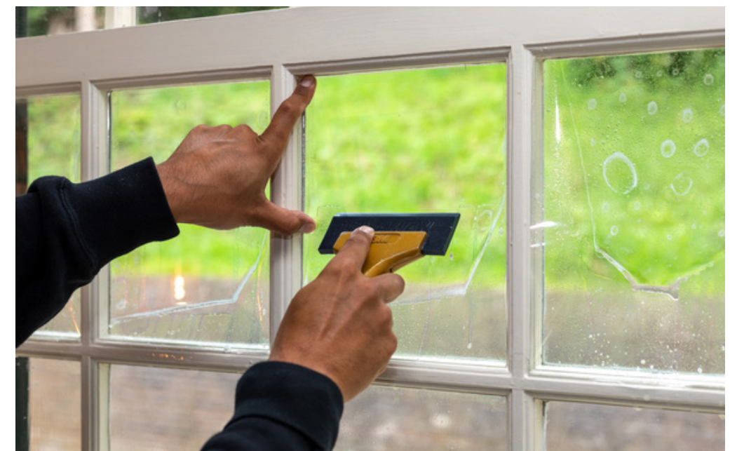
► Afbeelding XIII Het aanbrengen van isolerende glasfolie is een maatregel die weinig overlast geeft, en een mooie verbetering van de isolatiewaarde van het glas oplevert.
