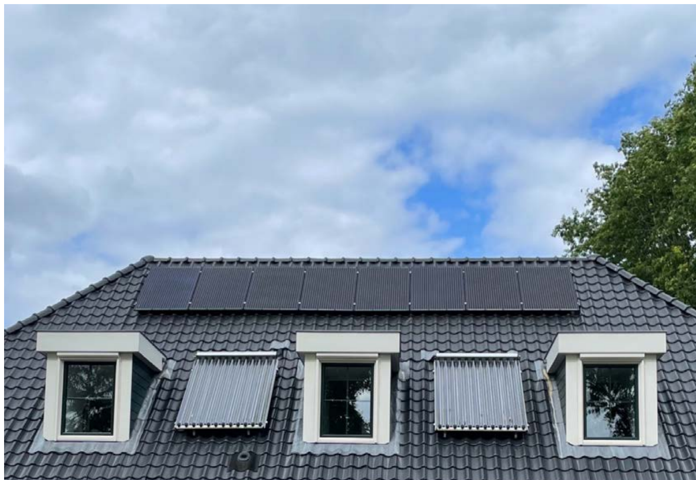
◀ Afbeelding 25 Bij dit huis wordt de energie van de zon goed benut: onder de nok zijn PV-panelen te zien tussen de dakkapellen vacuümbuiscollectoren.
