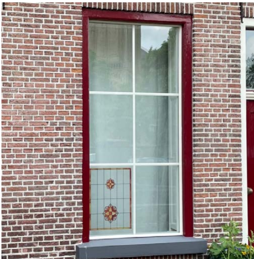
▲ Afbeelding XXVII Voormalig schuifraam waarbij het bovenlicht en onderaam zijn vervangen door één plaat dubbelglas die direct in het kozijn is vastgezet met glaslatten, met kunststof roeden in de spouw van het dubbelglas.
