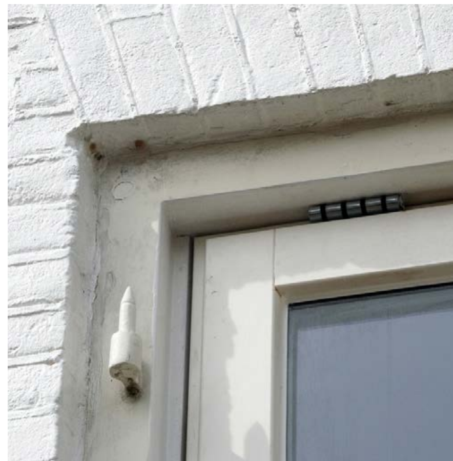
▲ Afbeelding XXIX Nieuw naar buiten kleppend bovenlicht in een historisch schuifraamkozijn, met dikker raamhout waardoor het raam verder naar buiten is gekomen, en met een verjonging aan de linker- en bovenzijde, voor de scharnier.
