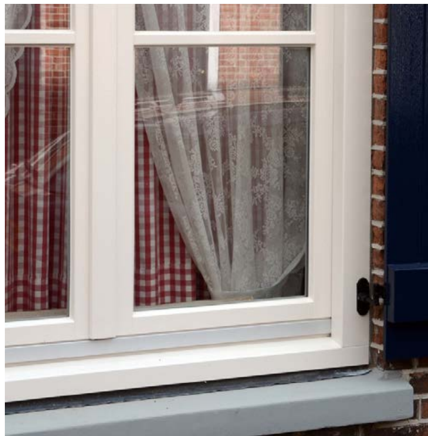
▲ Afbeelding XXVIII Nieuw naar binnen draaiend stolpstel met een aluminium aanslagprofiel aan de onderzijde, dubbelglas, plakroeden en v-groeven.
