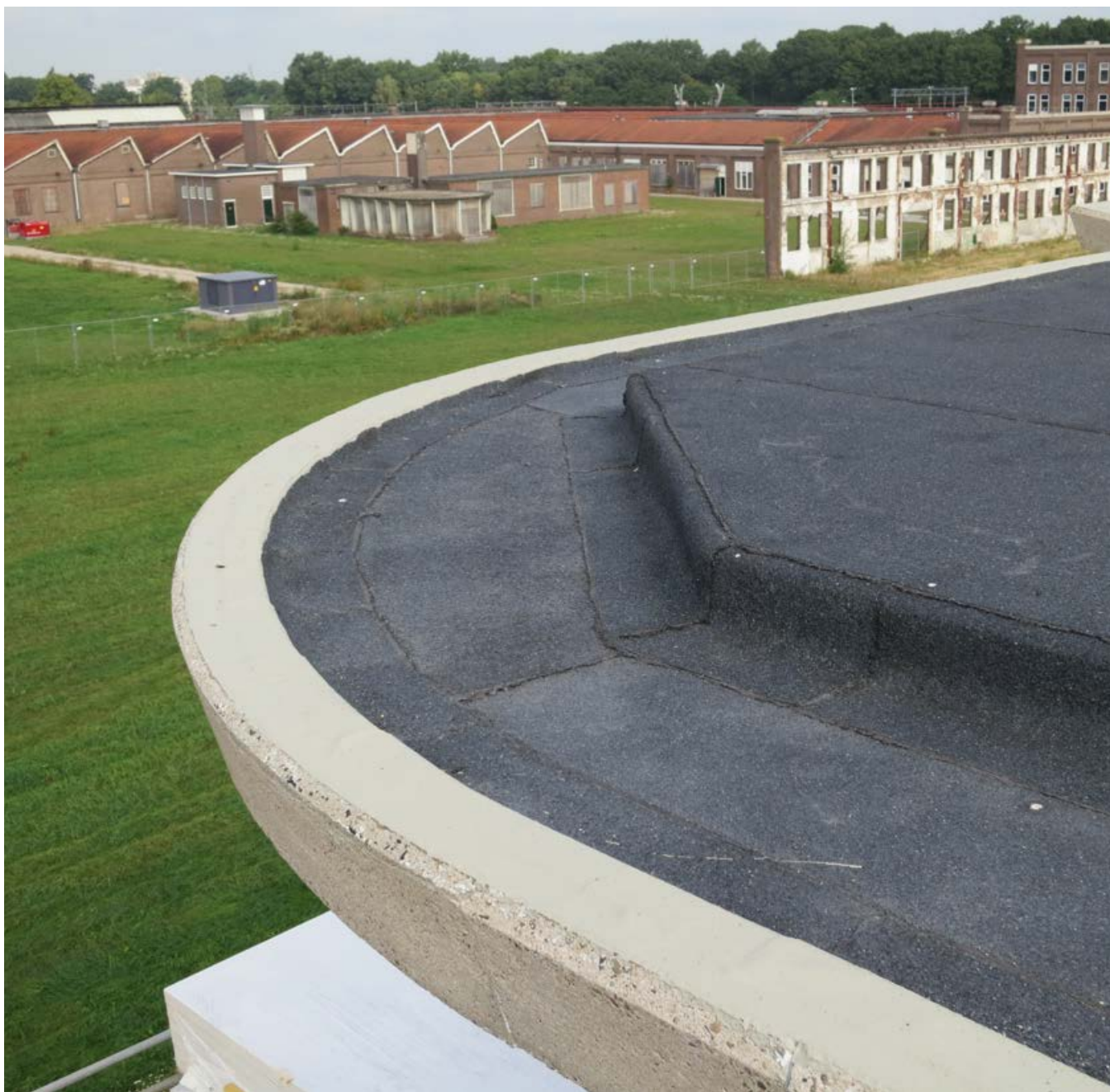
▲ Afbeelding XLV Dakisolatie met verjonging bij de dakrand in de gemeente Ede. Door de isolatie aan de rand dunner uit te voeren blijft het aanzicht van de dakrand hetzelfde.
